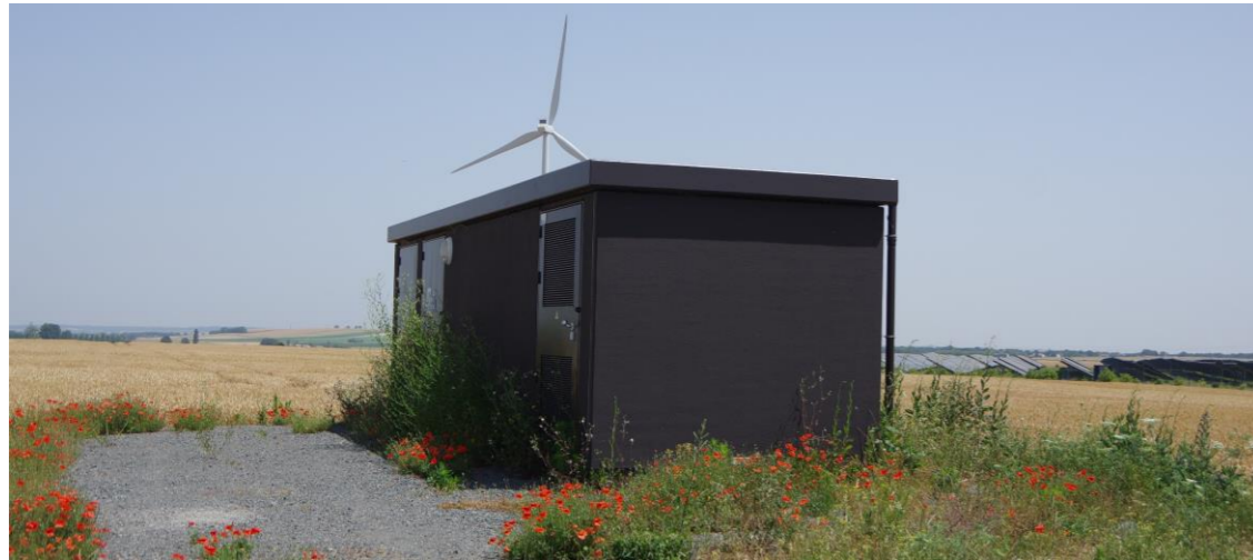
Photo 26 : poste de livraison dans des coloris gris sombre
