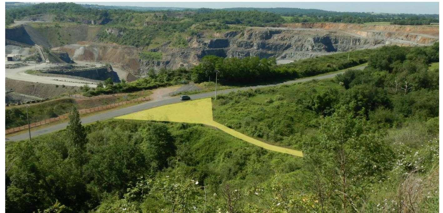
Figure 5 : vue depuis la butte des Tonnelles sur la future piste d'accès (matérialisée en jaune) raccordée à la RD135
